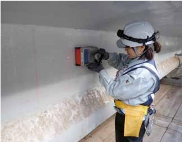
▲鉄筋探査状況(ストラクチャスキャン)
