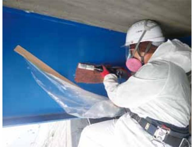
▲ 超音波はく離機による塗膜のはく離状況
